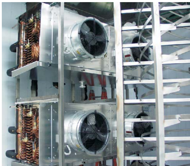
Rys.8. Chłodnice ICE w wykonaniu do zastosowań zamrażania szokowego
