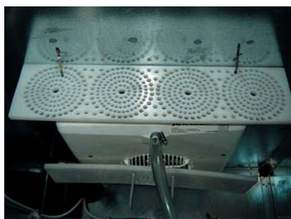
Rys. 4. Chłodnica powietrza zaopatrzona przewizorycznie w polaryzatory
