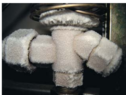
Rys. 9. Typowe oszronienie zaworu
