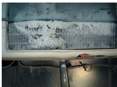
Rys. 7. Oszronienie chłodnicy w konfiguracji tradycyjnej (praca ciągła)
