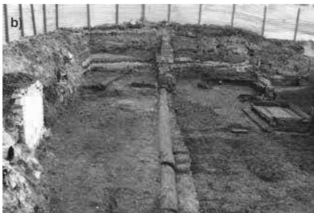
Rys. 1. Prace archeologiczne przy ul. Długie Ogrody, październik 2014 r.: a) rurociąg drewniany i latryna na poziomie fundamentów dawnych kamienic, b) złączka ołowiana (materiały GIWK, fot. M. Klugmann)
