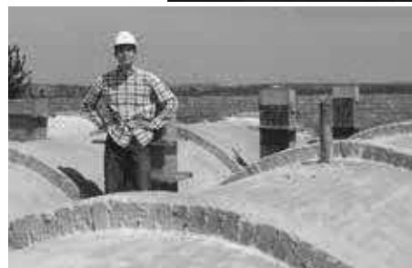
Rys. 3. Budowa zbiornika Stara Orunia, 1869; wewnątrz zbiornika, 2010; remont kapitalny, 2016 (ze zbiorów Biblioteki Gdańskiej PAN; materiały GIWK, fot. M. Klugmann)
