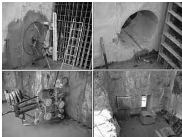
Rys. 7. Wycinanie otworów kołowych i o dowolnych kształtach w ścianach, stropach i innych elementach konstrukcji budowlanej [31]
