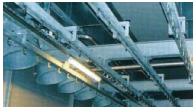
Fot. 2. Wentylatory i wymienniki ciepła w tunelu wychładzalniczym
