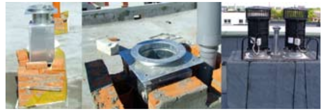
Zdjęcia pokazujące montaż skrzynki tłumiącej i nasad na czapie kominu
